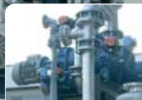
•Przemysł spożywczy: proces suszenia próżniowego. Dmuchała wysokiej próżni zastosowana jako urządzenie podnoszące wydajność układu.
