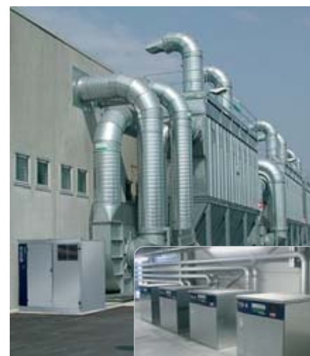
•Przemysł: Transport pneumatyczny wiórów drewna przy wykorzystaniu agregatu ROBOX evolution.
